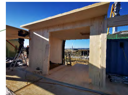
Structure CLT multi-niveaux
