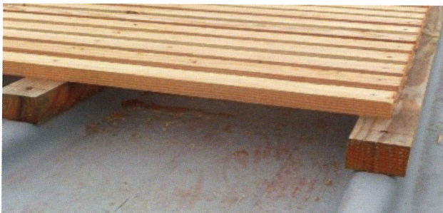
Platelage bois porte neige en toiture
