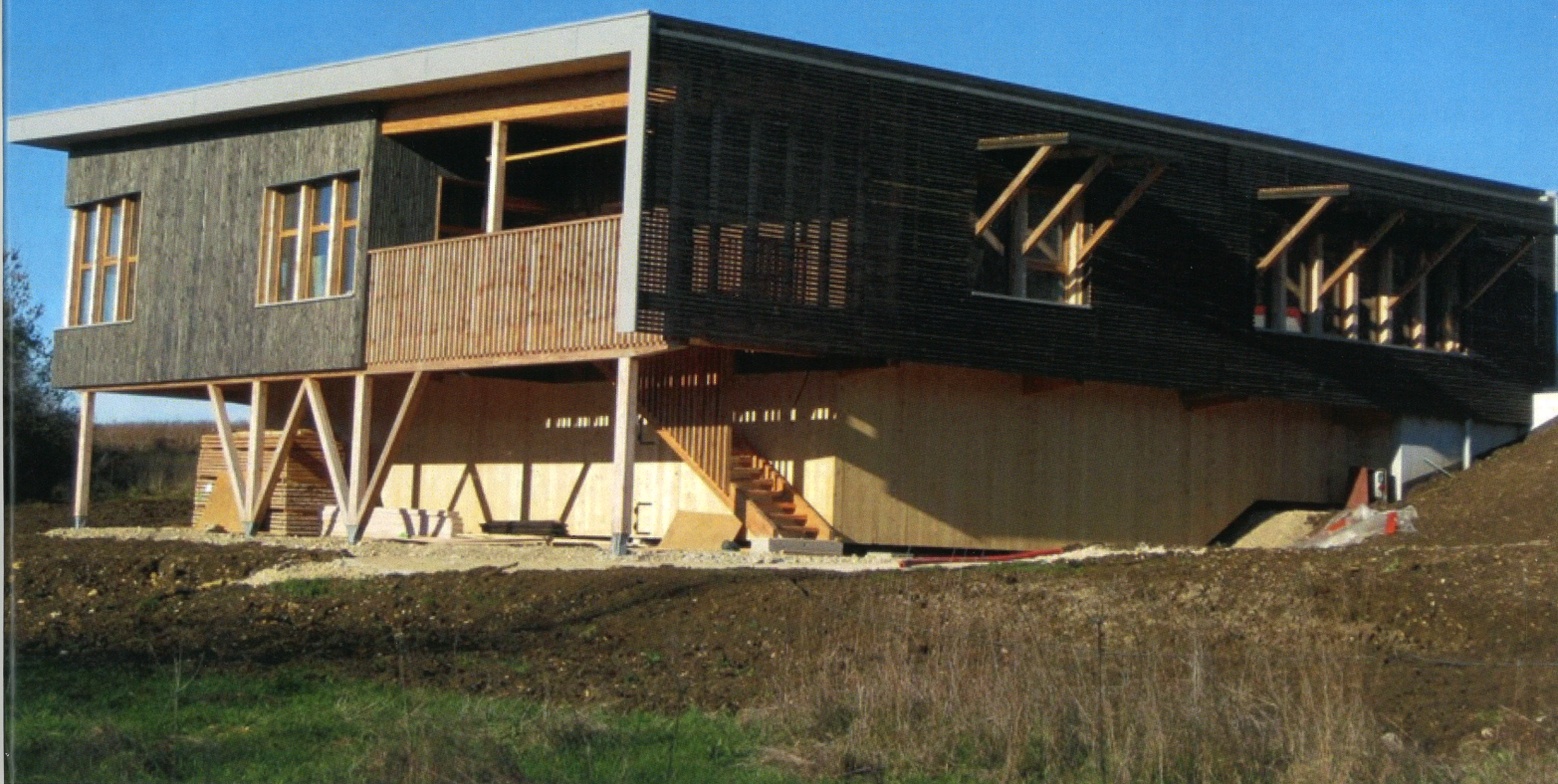
Vue Sud Ouest
