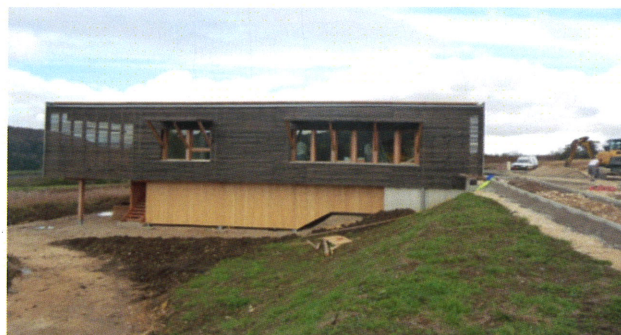
Façade Sud du bâtiment dans la pente
