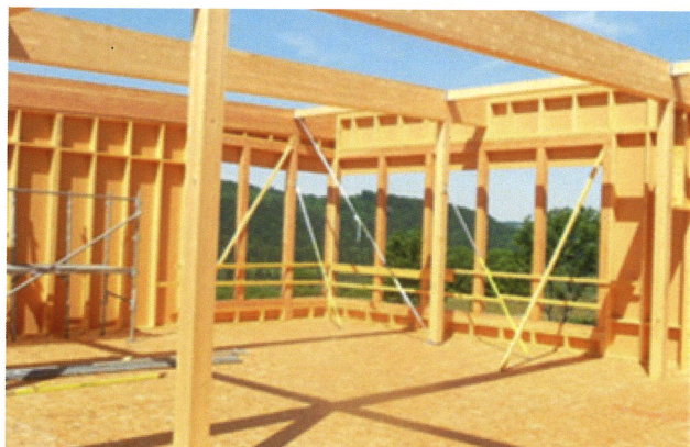
Structure poteau poutre
