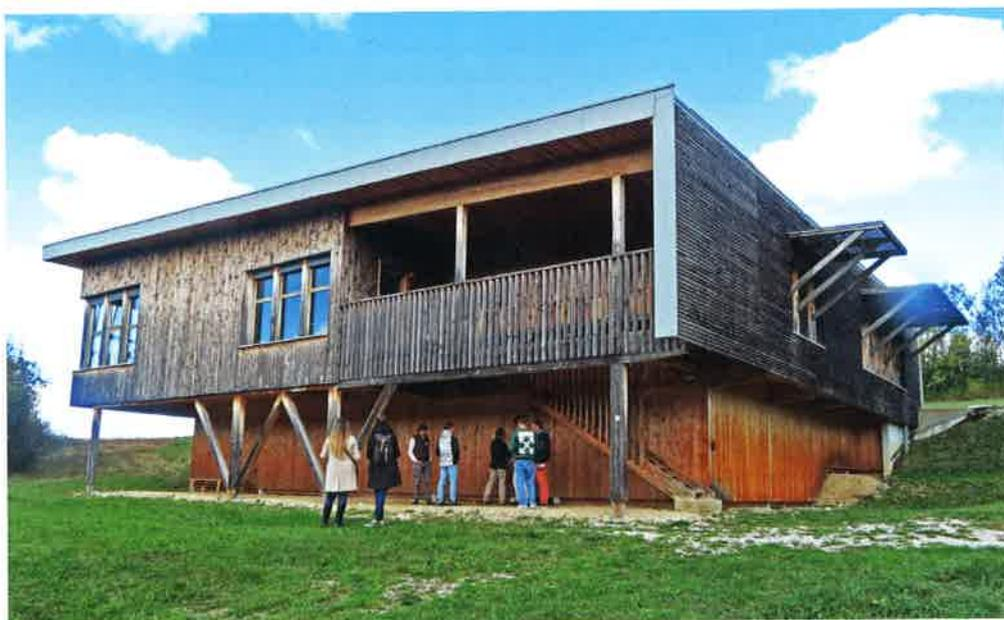
*le paysage, une construction sur pilotis pour préserver les sols, dans un milieu très humide avec beaucoup de passage d'eau. Toutes les menuiseries extérieures sont en chêne, la toiture en douglas, la vêtture en bois prégrisés, les bardages des parties les plus abritées en peuplier thermotraité ou en sapin. Et l'on voit aujourd'hui comment le bois a pris une belle patine. À l'intérieur, la vêtture est en épicea, le parquet en chêne huilé.*
