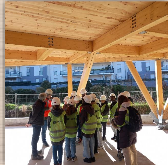
Visite du chantier de la Maison Solidaire par des collégiens de St Genis Pouilly
