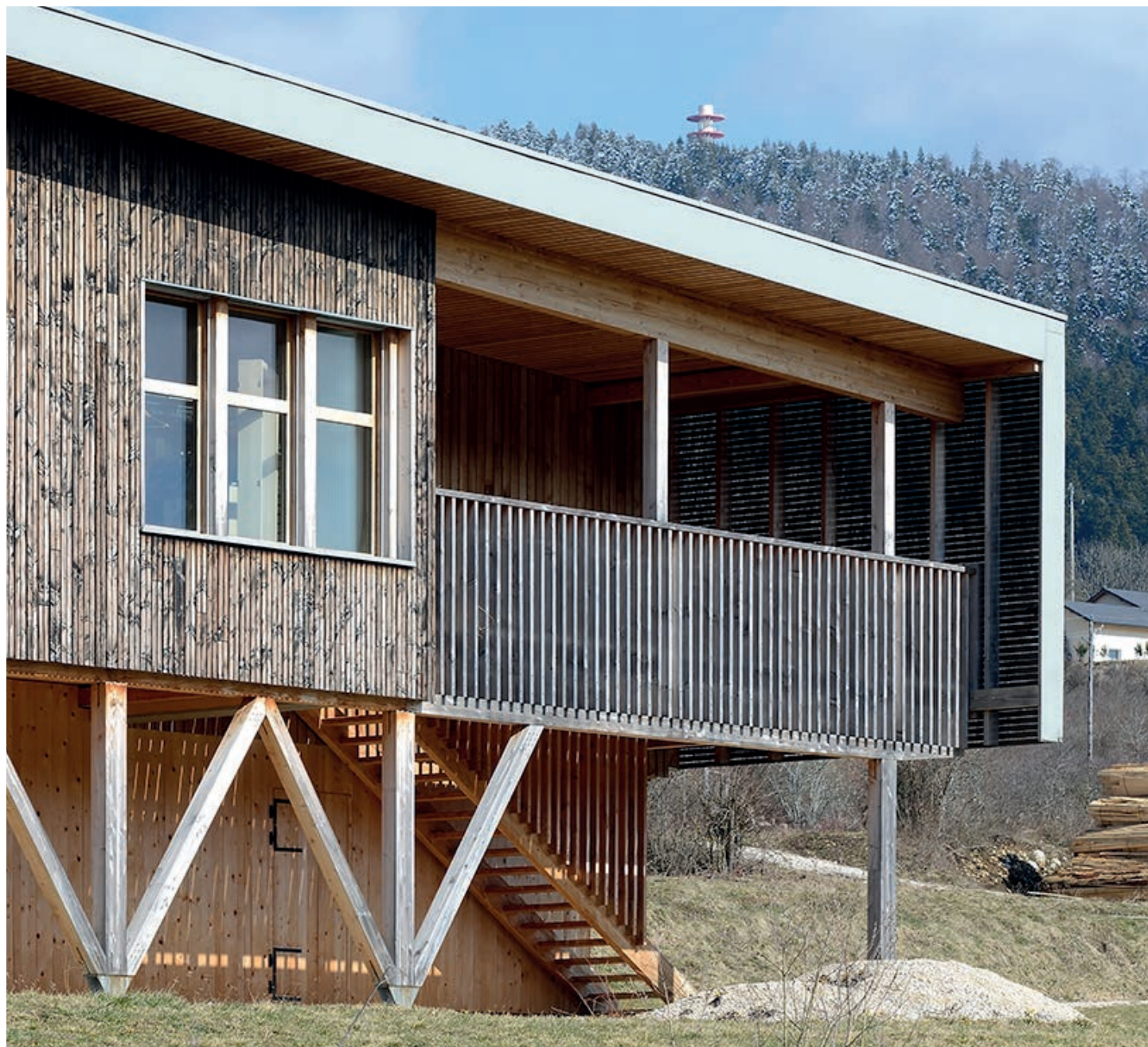
Visiobois – Maison de la filière bois de l'Ain Plateau d'Hauteville (01) Bâtiment construit en bois local
