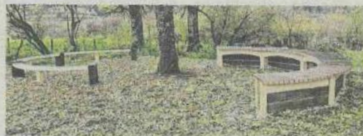
Les bancs ont été réalisés en utilisant la technique du lamellé-collé cintré. Photo Guy Domain
