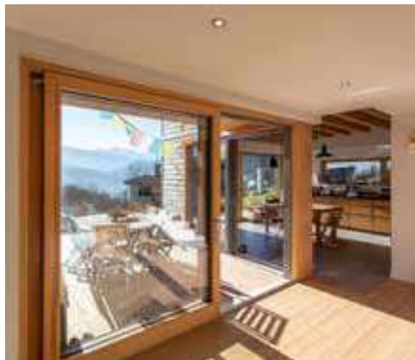
Menuiseries extérieures bois/alu en pin sylvestre - Face à Belledonne (38) - ©Jim Prunier - Gasnier-Eco Architectes
